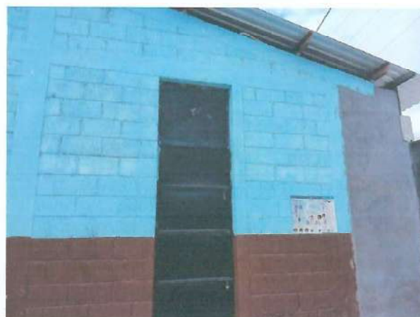
Foto 2: Reparación y cernido de paredes
