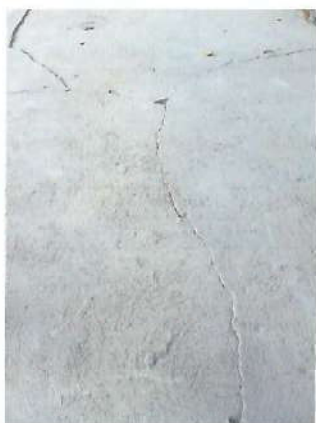
Foto 3: Mejoramiento y sustitución de piso
