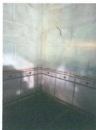
Foto 2: Reparación de área de cocina (mejoramiento de lavamanos, paredes)
