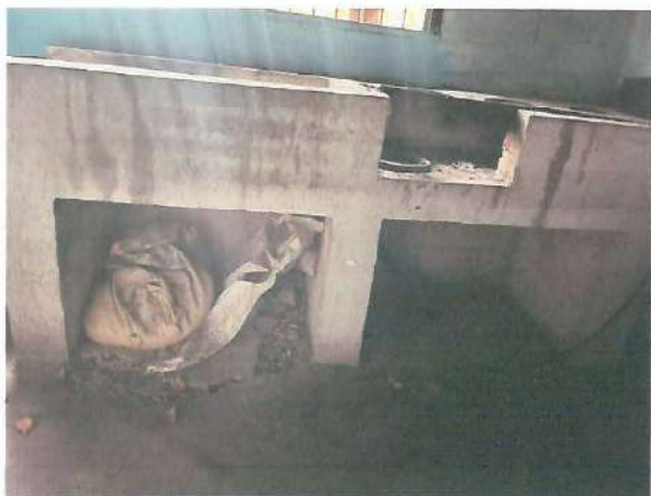
Foto 1: Reparación de área de cocina (poluteon, chimenea)
