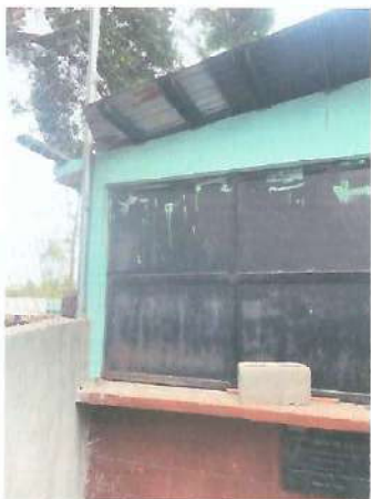
Foto 1: Reparación y cernido de paredes
