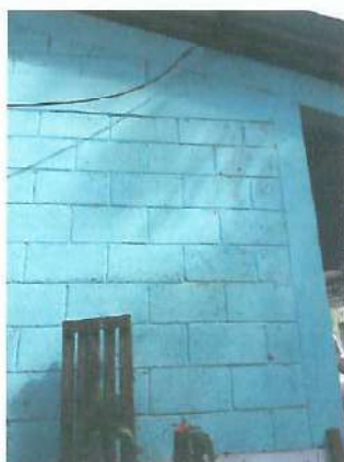
Foto 3: Reparación y cernido de paredes
